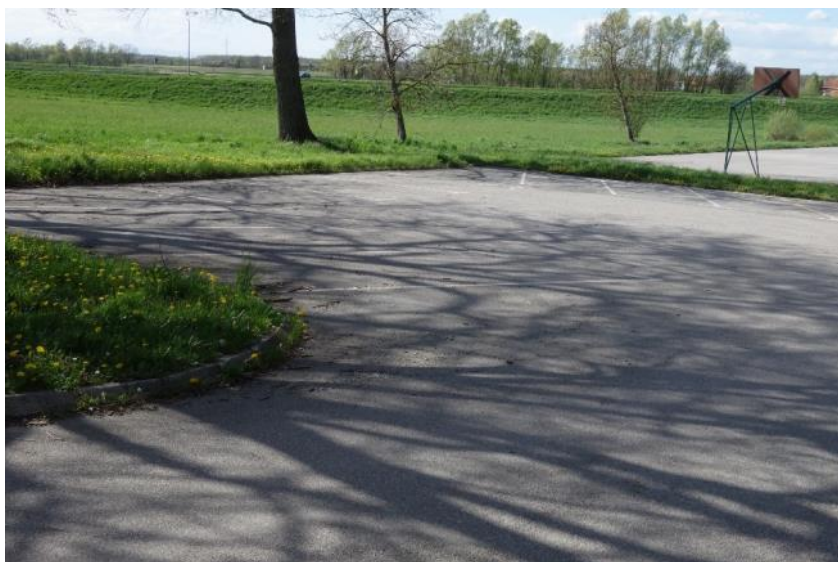
Objekti vanjskog uređenja— asfaltirane i manipulativne povr- šine
